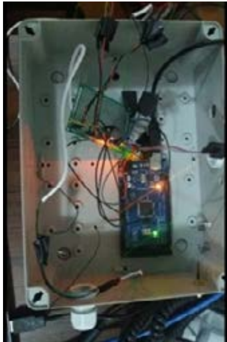
Figura. 1 – Montagem Cx. Sensores
